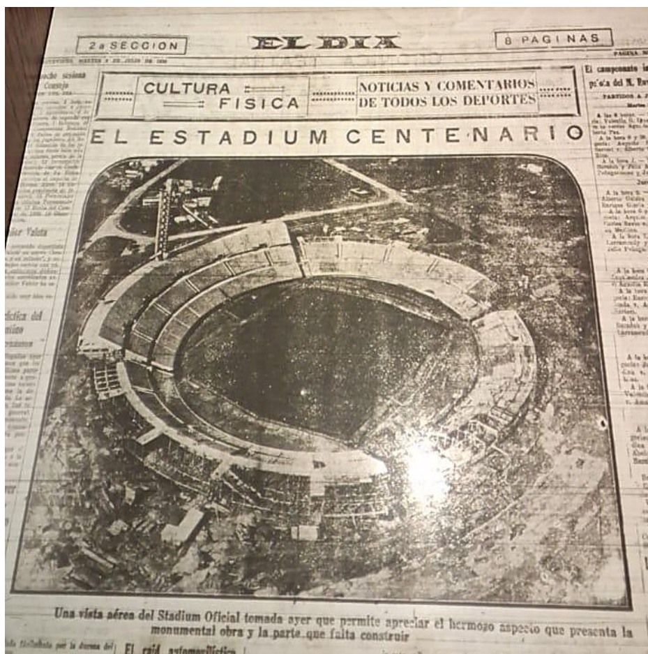
Figura 17 – Fotografia aérea das obras do Estádio Centenário 10 dias antes de sua inauguração. 129
